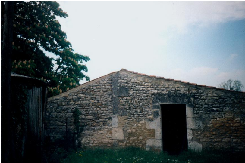
Backofen-Gebäude von der Eingangsseite her betrachtet
