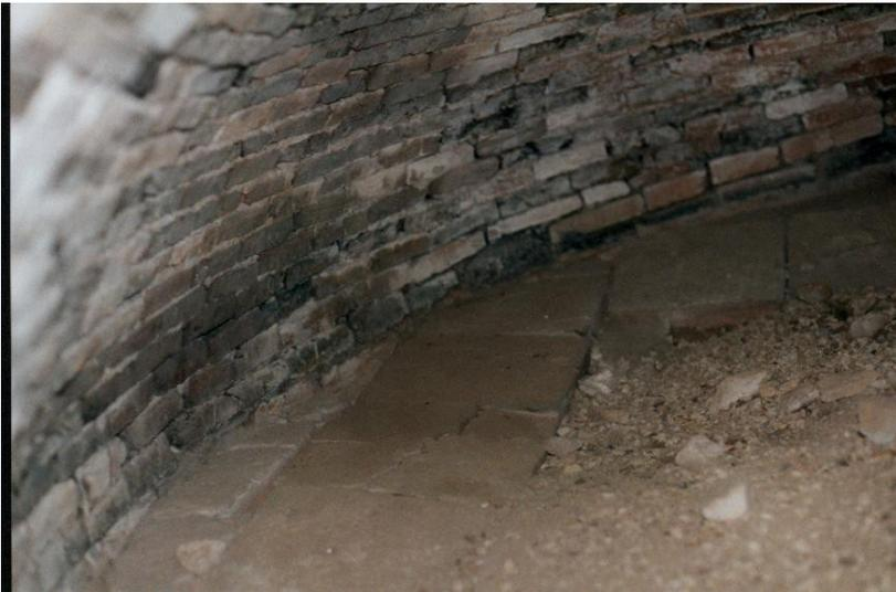
Detail-Foto des hinteren linken Teils mit dem verfallenen Backboden bestehend auch hier aus dicken Ziegel-Platten.
