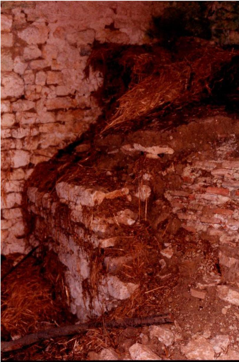
Der beschädigte „Hinterteil“ des Backofen. Nicht gut aber immerhin zu erkennen, die Ummantelung des Gewölbes mit Lehm und Umbauung mit einer Futter- oder Stützmauer. Das ganze befindet sich in einem Schopf, also in einem wenngleich offenem doch überdachten Anbau.
