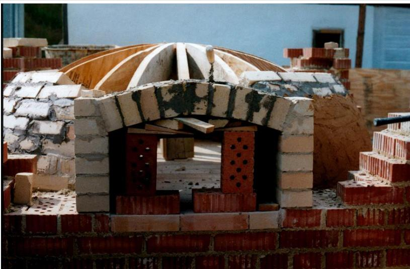
Deutlich zu erkennen: Das Gewölbe wird gegen den zuerst errichteten Tor-Rahmen gemauert.
