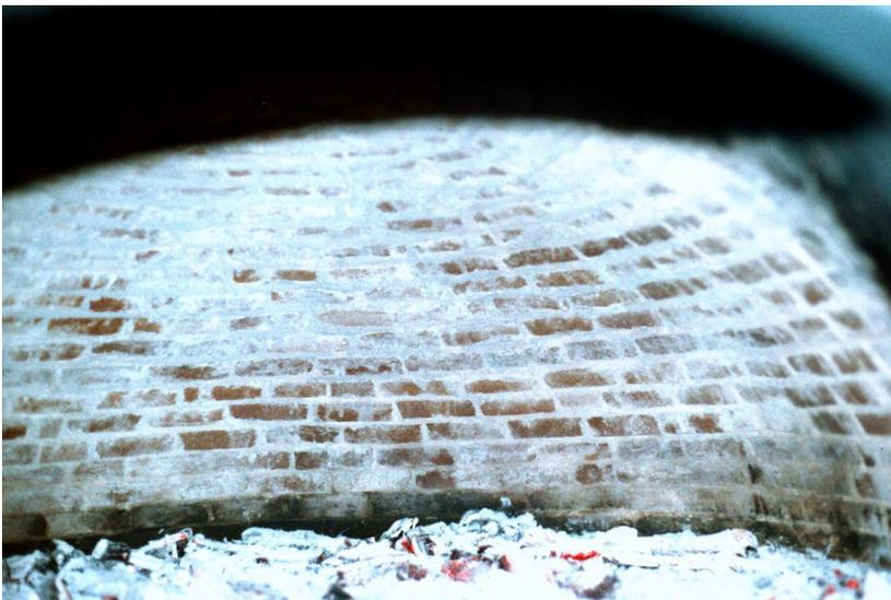
Der Ofen hat die richtige Temperatur - obwohl das Thermometer in der Mitte der Gewölbedicke (10 cm oberhalb der Gewölbe-Innenfläche) nur ca. 130°C anzeigt. Nun die Scheite ca. ½-Stunde zu Ende brennen lassen, die Asche vorsichtig beiseite schieben, dann bleibt der Ofen noch eine halbe Stunde bei geschlossener Tür „stehen“ - In der Fachsprache : Der Ofen „steht ab“. Während dieser Zeit verteilt sich die Wärme von der heißen Oberfläche nach innen, das Thermometer steigt weiter auf bis 150°C an.
