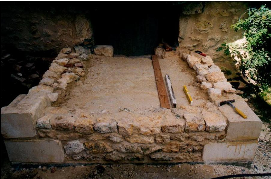
Die vierte Lage ist bereits fertig. Man beobachtet, daß diese rechts im Bild mit der Höhe des Ecksteins abschließt. Der nächste, der dritte, rechte Eckstein, wird wie der erste über diese Lage gelegt.
