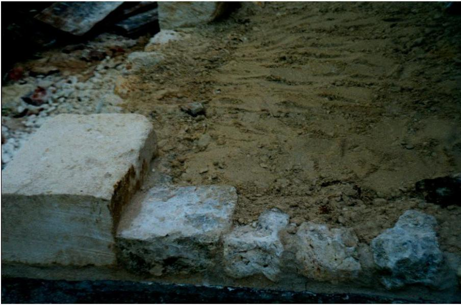
Der Innenraum wie auch die größeren Zwischenräume zwischen den Steinen werden mit einem weichen Kalkstein-Beton aufgefüllt
