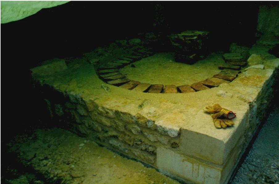
Unter Aussparung des Raumes für die Grundfläche des gesamten Backofen-Gewölbes, die aus einem feinen Mörtel bestehen soll, wird die Sockelmauer mit dem Kalkstein-Beton aufgefüllt.
