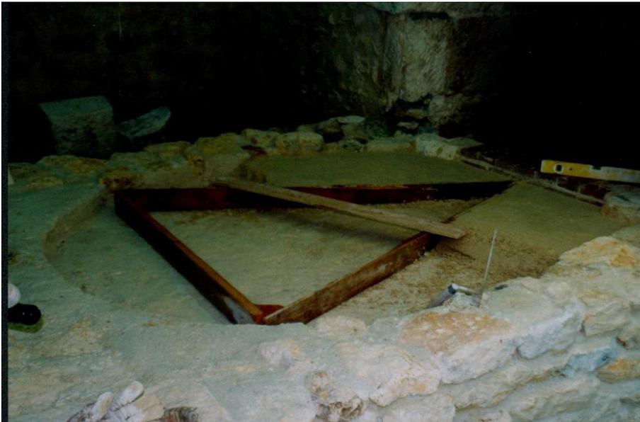
Gießen der Grundfläche für den Backofen aus einem feinsandigem Luft-Mörtel mittels einer Schablone zur Erreichung einer ebenen und waagerechten Fläche
