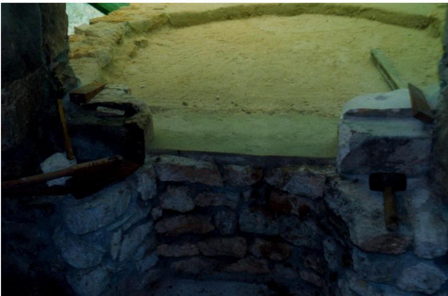
Als nächstes wird hier der Vorbau, also der Sockel auf der Innenseite des Backhauses unter möglicher Beibehaltung der alten Steine restauriert.
