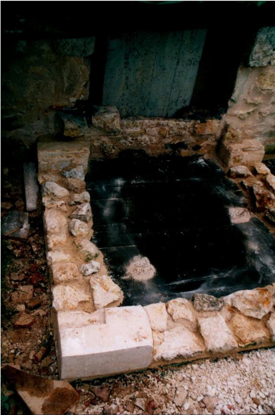
Die erste Doppel-Reihe der Futtermauer des Sockels aus Bruchsteinen ist gelegt. Die Fundamentoberfläche wurde vorher mit einer Lage Dachpappen gegen aufsteigende Feuchtigkeit geschützt.
