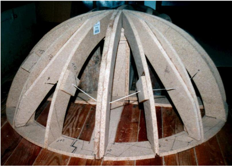
Hier zu sehen: Die Verspannung des hinteren Teil des Modells mit Seilen. Auch zu beobachten, die Verstärkung der Spante durch Verdoppelung
