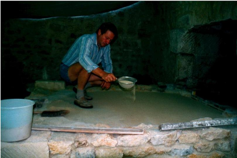
Die erste Schicht des Backbodens beginnt mit einer dünnen Schicht aus feinem Sand aufgetragen wie zu besichtigen - mit einem Küchensieb
