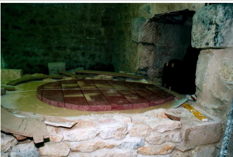
Der fertig gelegte Backboden in Form des darauf zu liegenden Modells, dessen unterer Teil hier für das Foto entfernt wurde.
