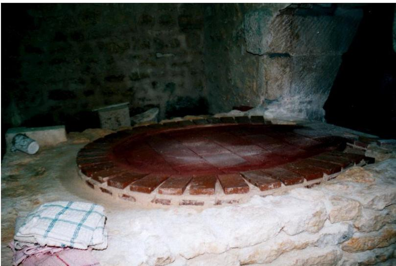
Die erste und zweite Lage um den Backboden bereits schon unter Berücksichtigung des Radius.
