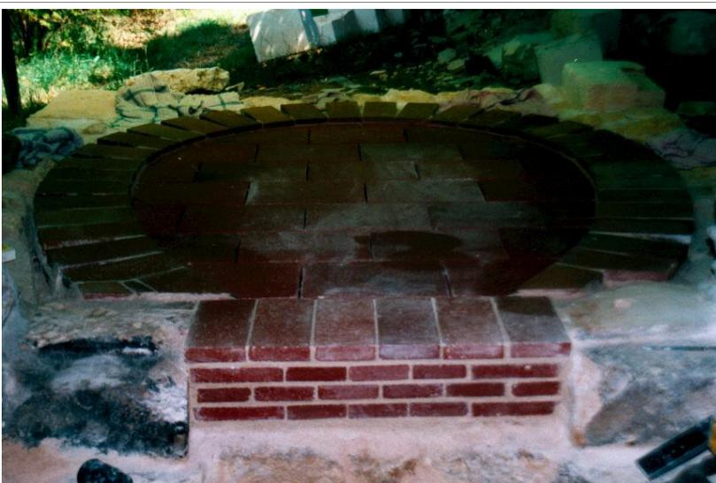
dito von innen fotografiert. Die zweite Lage schließt - ungefähr - mit der Oberkante des Sockels für den Tor-Rahmen bzw. Umgebung ab.
