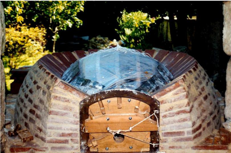
Lage 10. Hier wurde endlich die Abstufung in der Lage 9 durch Einsatz eines angeschliffenen Ziegels korrigiert, so daß die Ziegel wieder eine durchgehende Ebene bilden.
