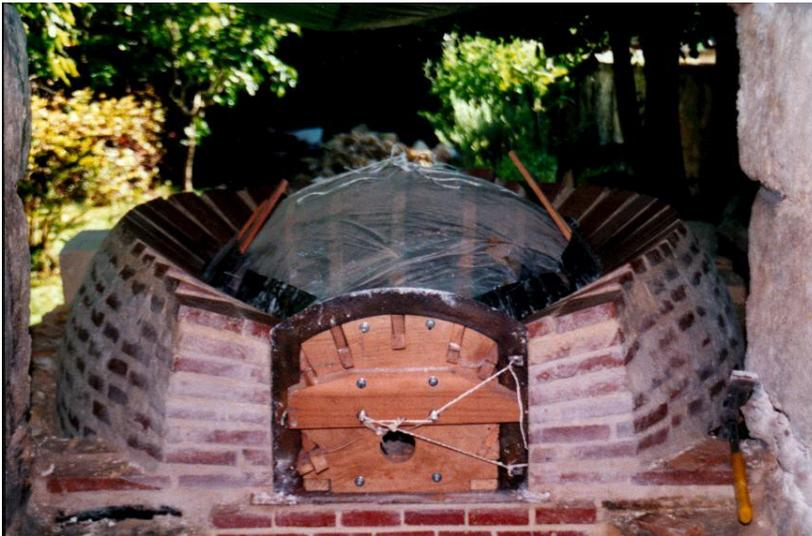
Lage 8: Man sieht deutlich: Es wird eine Beplankung des Modells benötigt, bestehend aus kleinen Blech-Platten, die mittels einer Kordel am Modell befestigt werden können. Sie werden nach leichtem Antrocknen des Mörtels vorsichtigst! gezogen.
