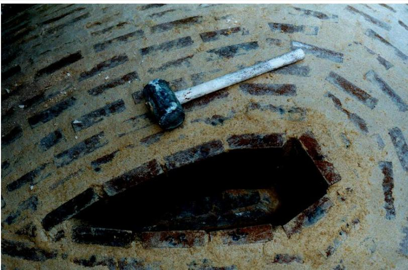
Lage 21. So langsam wird es sehr kompliziert. Muße und Disziplin bei der Vorbereitung der wird auf eine harte Probe gestellt; denn - kaum der Mörtel aufgetragen, muß man festst Berechnung der Mörteldicke nicht korrekt wa ganzen Lage, Abwaschen der Oberfläche, Kor der Ziegel.
