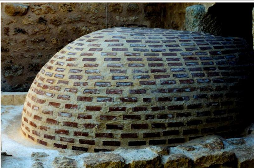
**Ordner 7.11: Bauabfolge 11: Aufbau der Gewölbe-Lagen 18 bis 22 oberhalb des Backbodens und Fe**
