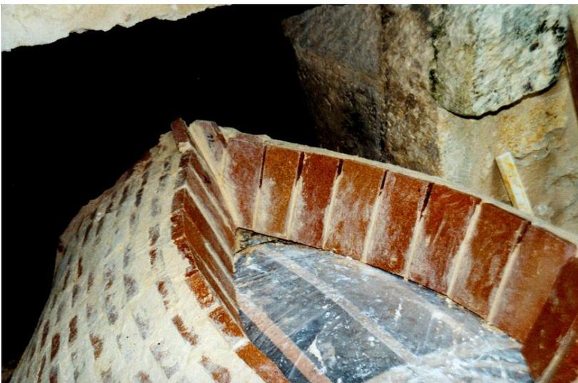
Lage 18. Detail-Aufnahme. Die Einarbeitung sich als enorm aufwendig. Hat man früher die Hammer geschlagen, so muß hier alles mit werden. Eine Lage entspricht einem Tageswerk einschließlich Vorbereiten und Nachbereiten
