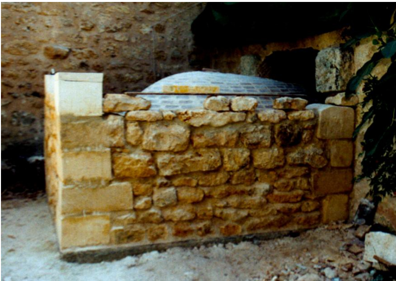
Die obere Futtermauer in der letzten Bauphase
