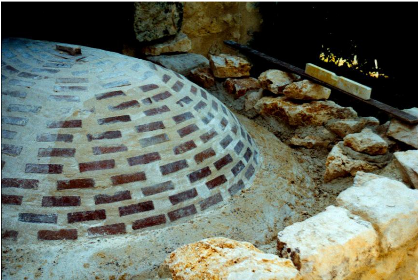
Detail-Aufnahme der Hinterfüllung
