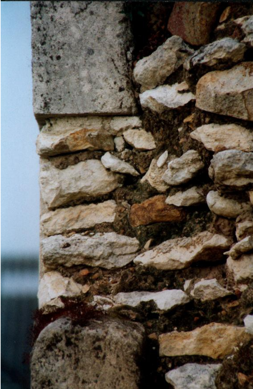
Detail-Foto einer Lage Bruchsteine zwischen zwei Ecksteinen.
