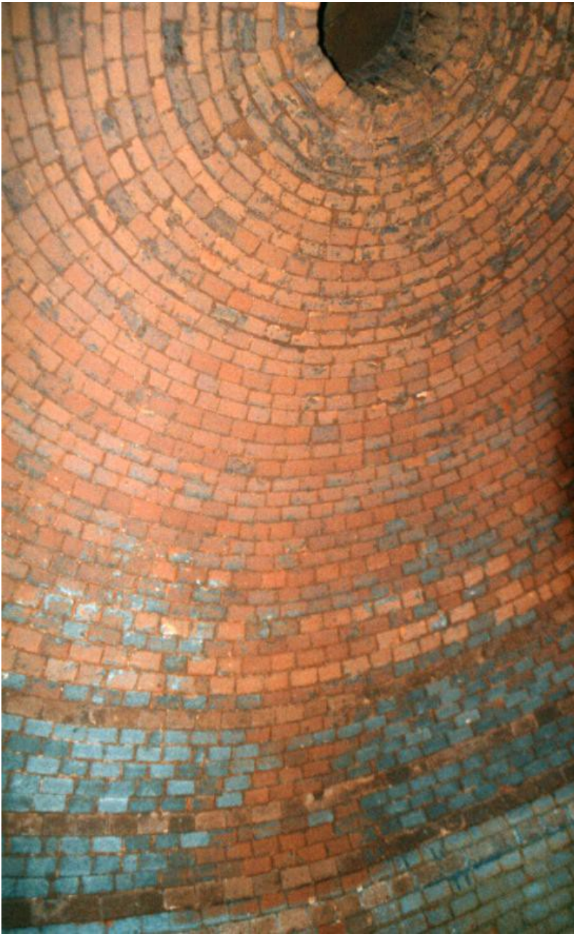
Die Decke des Ofen-Gewölbes mit Abgas-Öffnung
